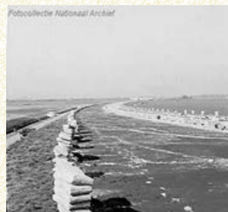
De A4 in aanleg tussen Hoogmade en Roelofarendsveen in oktober 1959.
